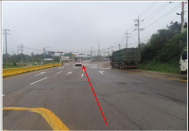
B-7구간 (Sta.184+0.0) 도로구간 - 비봉사거리
