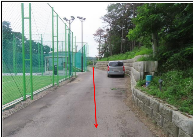
B-6구간 (Sta.163+0.0) 도로구간 - 폐도로
