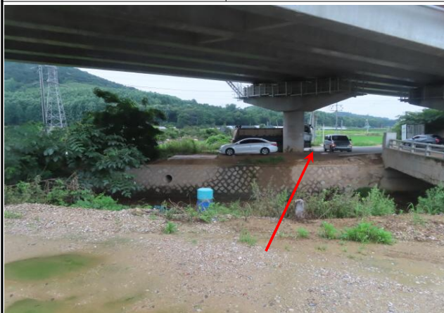
B-8구간 (Sta.228+5.0) 하천 횡단구간
