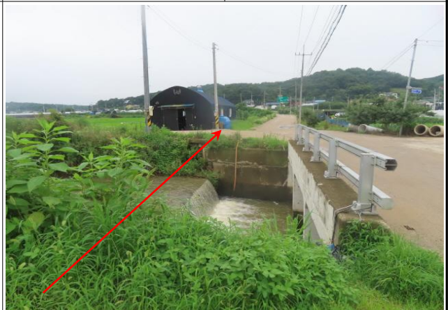
B-8구간 (Sta.278+20.0) 하천 횡단구간 - 소하천
