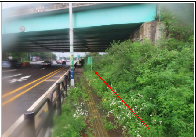
B-6구간 (Sta.170+0.0) 나대지
