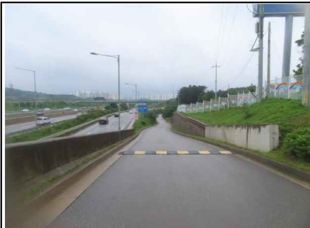
A LINE 시점부 전경
