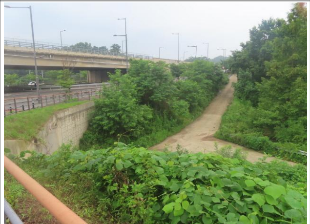
G LINE 시점부 전경
