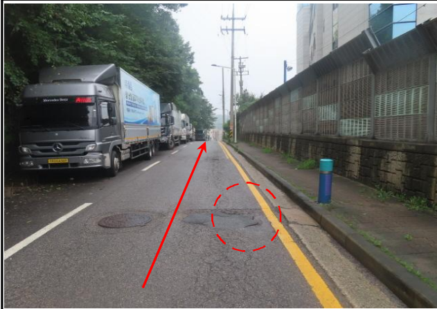
B-7구간 (Sta.173+0.0) 도로구간
