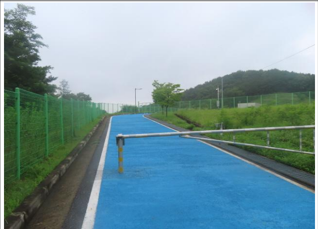
D LINE 시점부 전경
